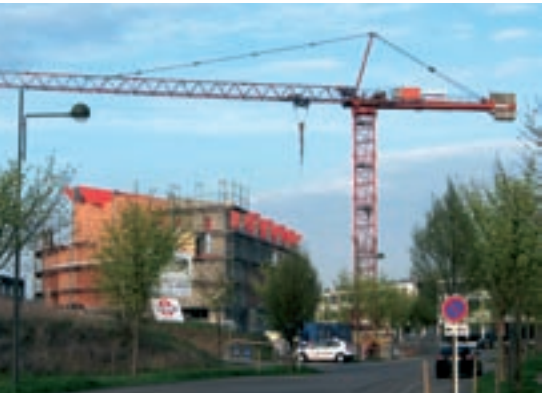
Der Bau von OIKOPOLIS II
