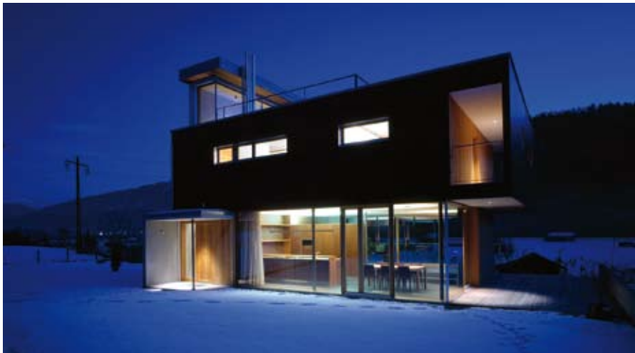
La construction d'une maison passive n'implique pas obligatoirement une faible ouverture lumineuse (photo : Christof Hrdlovics)
