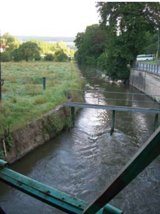
Die Wassermühle in Moestroff (Foto: Serge Medinger)
