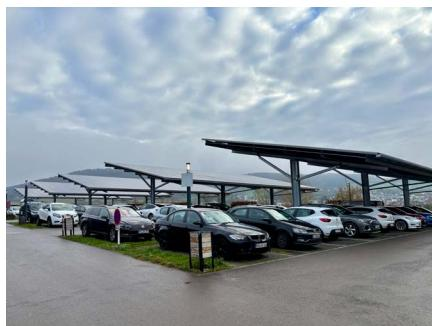
La société Panhelios S.A. a réalisé une installation photovoltaïque d'une puissance de 921 kWp sur un parking existant de l'entreprise Panelux S.A. (14, Rue Strachen, L-6933 Mendsdorf). L'installation sous forme de carport
